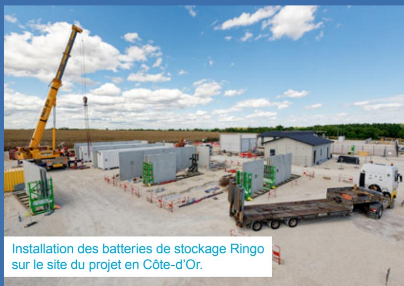
Installation des batteries de stockage Ringo sur le site du projet en Côte-d'Or.
